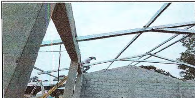
Foto 1: La fotografía evidencia el avance de cambio de techo del Centro Educativo.
