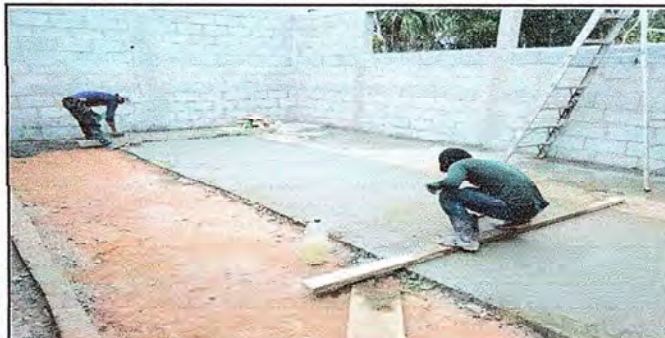
Foto 2: Esta fotografía señala la realización de la construcción del piso de concreto en el aula del Establecimiento Educativo.
