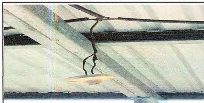
Foto 3: Aquí indica como fue el proceso de los cambios de accesorios y conexiones eléctricas.
